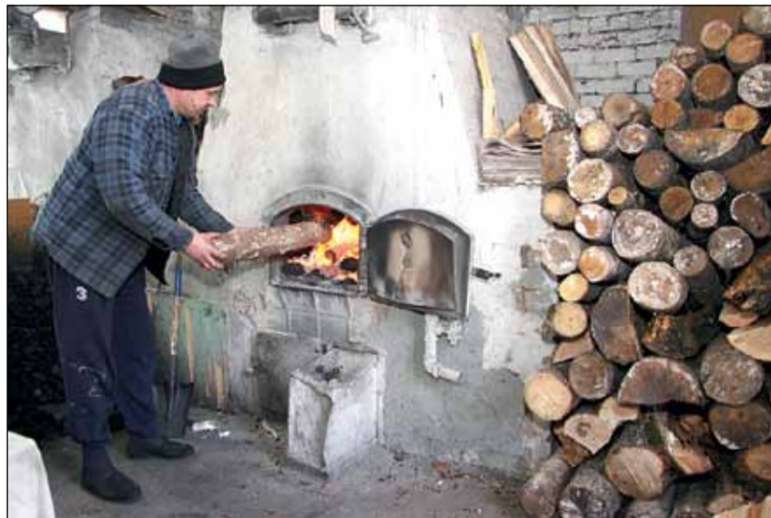
FOTO: Līvberzes pagasta Aizupes pamatskolas veco katlumāju plānots atjaunot, blakus uzbūvēs kurināmā novietni, bet virszemes siltumtrasi demontēs un izbūvēs jaunu – pazemē.
