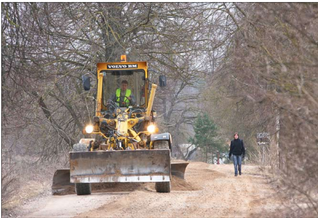
FOTO: Ceļa klātnes planēšanu jeb greiderēšanu visu Jelgavas novada pagastu teritorijās veic SIA «Roplainis», kas izraudzīta konkursa kārtībā, – uzņēmums apņēmis kilometru ceļa nogreiderēt par 18 latiem.
