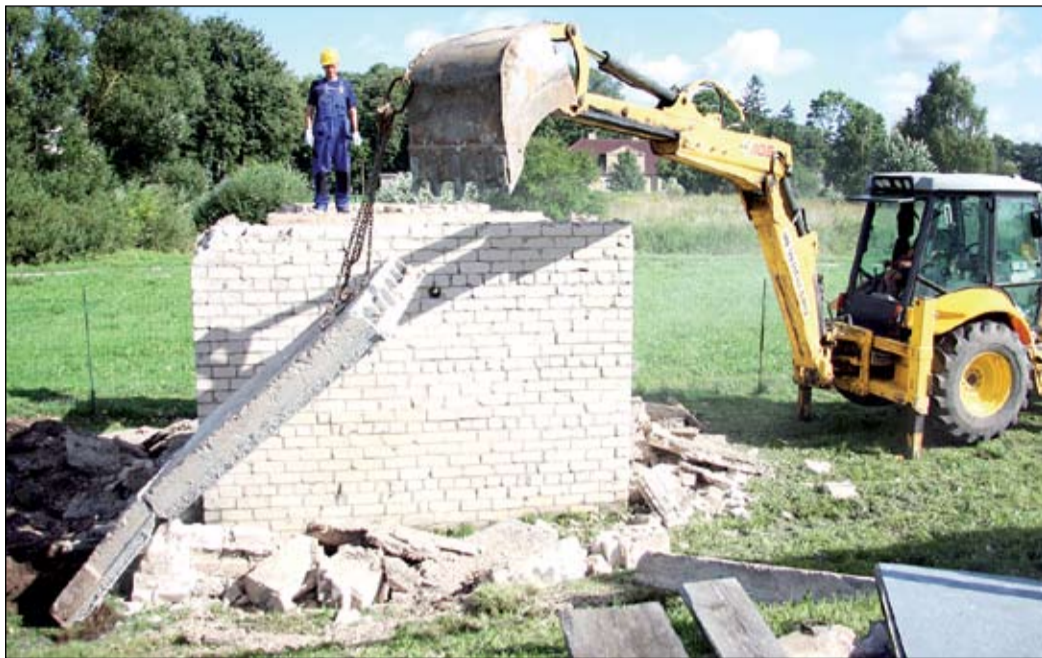
FOTO: Ūdensapgādes sistēmas rekonstrukcija Stalģenē sāka ar vecās sūkņu stacijas nojaukšanu.
