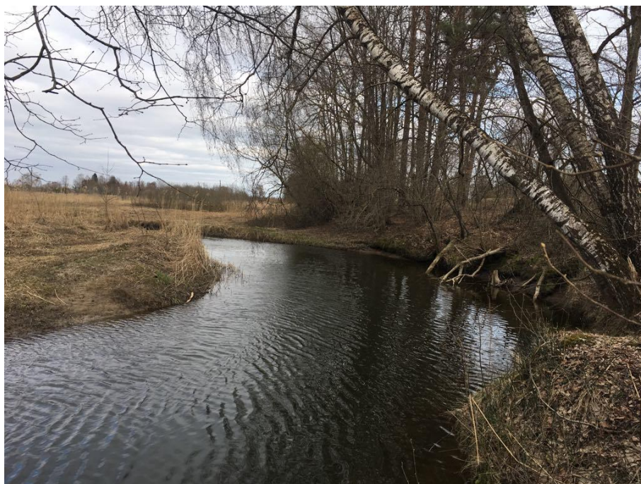
16.attēls Svētes upes krasta erozija piketā 127/60
