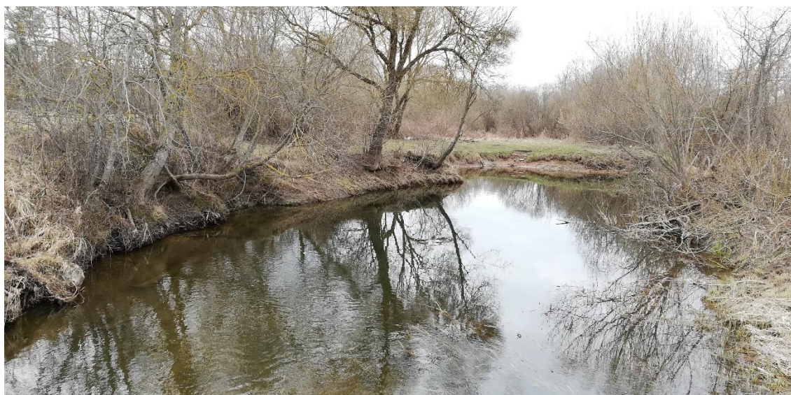
18.attēls Svētes upes krasta erozija pietā 167/50
