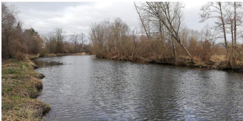
6.attēls Svētes upes krasta erozija pietētā 67/00
