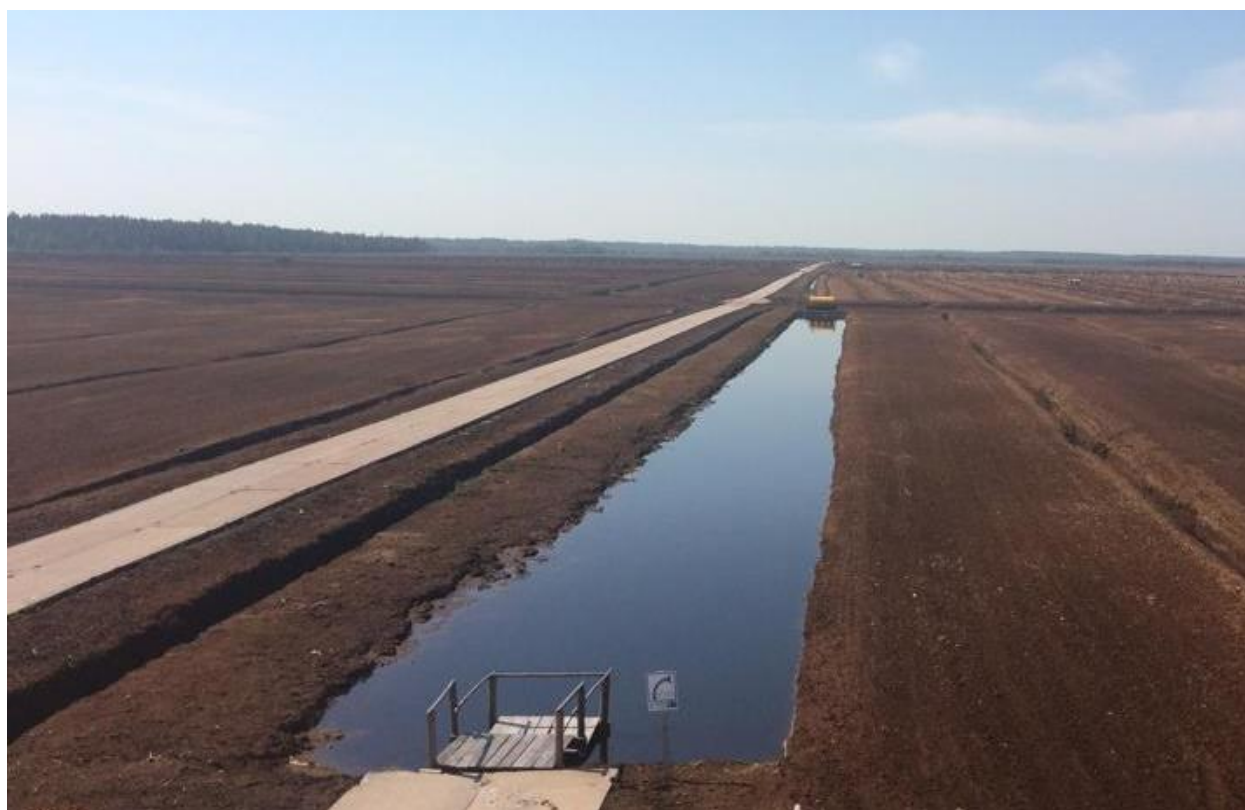
1.23. attēls. Dzelzsbetona plātņu autoceļi kūdras ieguves lauku teritorijā
