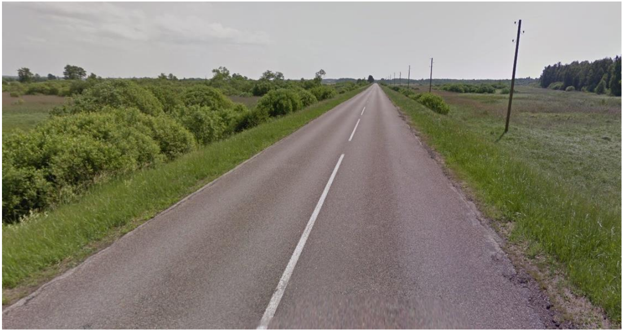
1.18. attēls. Valsts vietējas nozīmes autoceļš V1091 Kalnciems – Kaiģi posmā no autoceļa A9 Rīga (Skulte) – Liepāja līdz Kalnciemam
