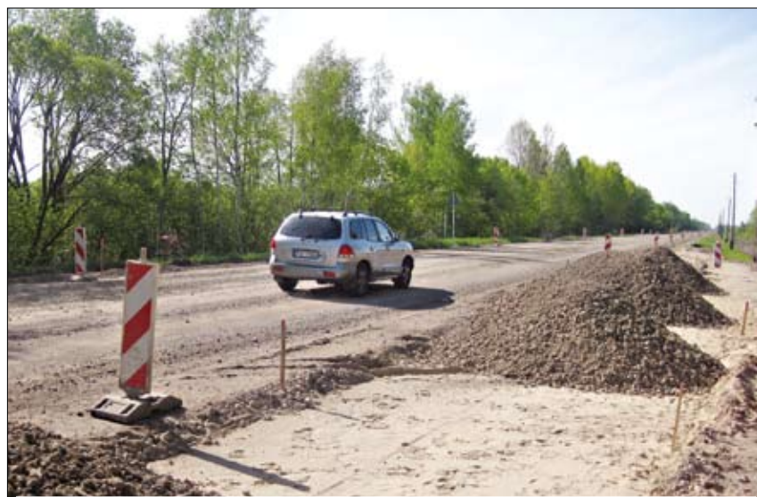
FOTO: Autoceļa A8 posma jeb Lietuvas šosejas rekonstrukcijas gaitā no 8,6 līdz 9 metriem tiks paplašināts esošais ceļa platums – galvenokārt uz ceļa nomaļu rēķina. Tieši tādēļ līdztekus citiem ceļa izbūves darbiem pašlaik tur norit zemes klātnes ierakumu un uzbēruma izbūve. Šī posma rekonstrukcija noslēgsies oktobrī.
