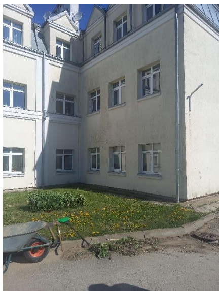
Ēkas fasāde ar telpu logiem
