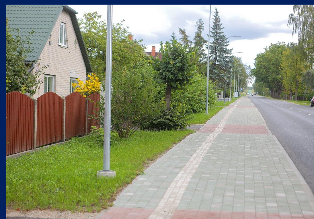
Garozas iela pēc pārbūves (999 m)
