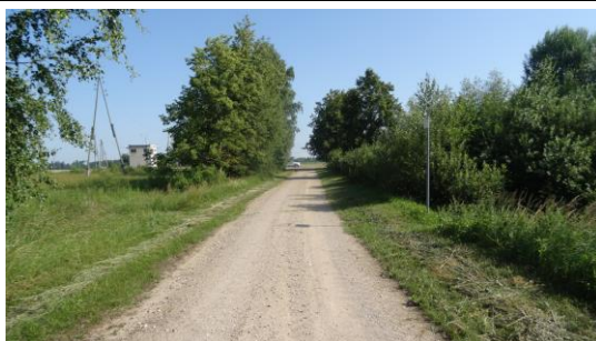
Pašvaldības autoceļš: Strupju iela
