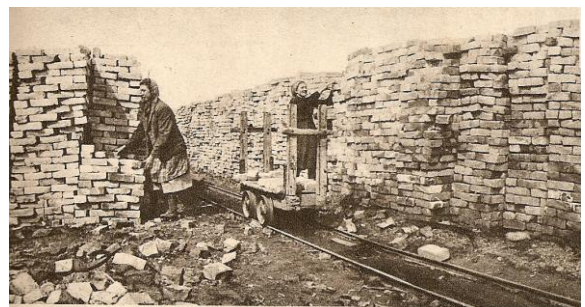
Ķieģeļu ceplis Kalnciemā
